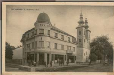
Budova Račického domu – na poschodí mal Teodor Jozef Mousson ateliér
