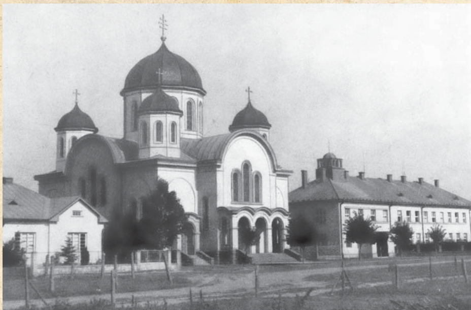
Kláštor a chrám (v súčasnosti bazilika minor) rehole redemptoristov
